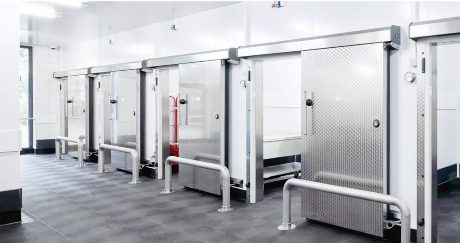
Die BASIC-CELL 100 ist unser Standard Kühlzellen System mit einem 100-mm-Raster, ohne Passelemente, Winkelverbindungen oder Sonderzuschnitte.
